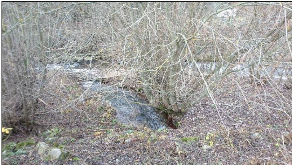
Obrázok 6: Vyústenie odtoku z priepadu vodojemu
