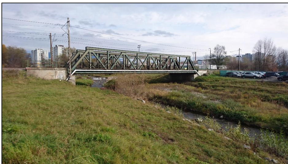
Obrázok 11: Príklad línie kamenného opevnenia na pravom brehu koryta Smrečianky medzi železničným a cestným mostom (priestor lokalizácie strojovne MVE)
