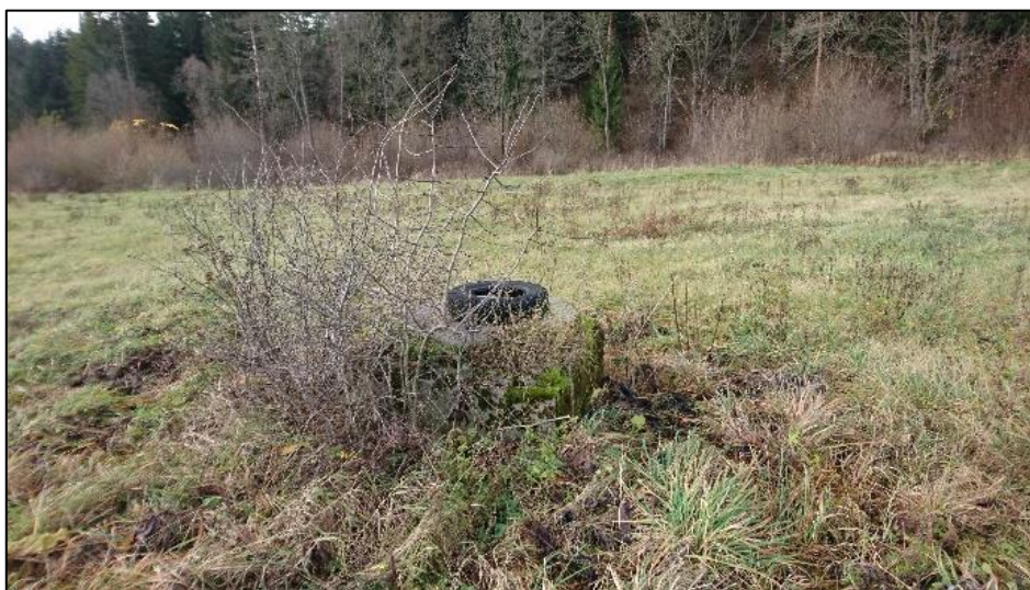
Obrázok 3: Kontrolná šachta na prívodnom potrubí do vodojemu
