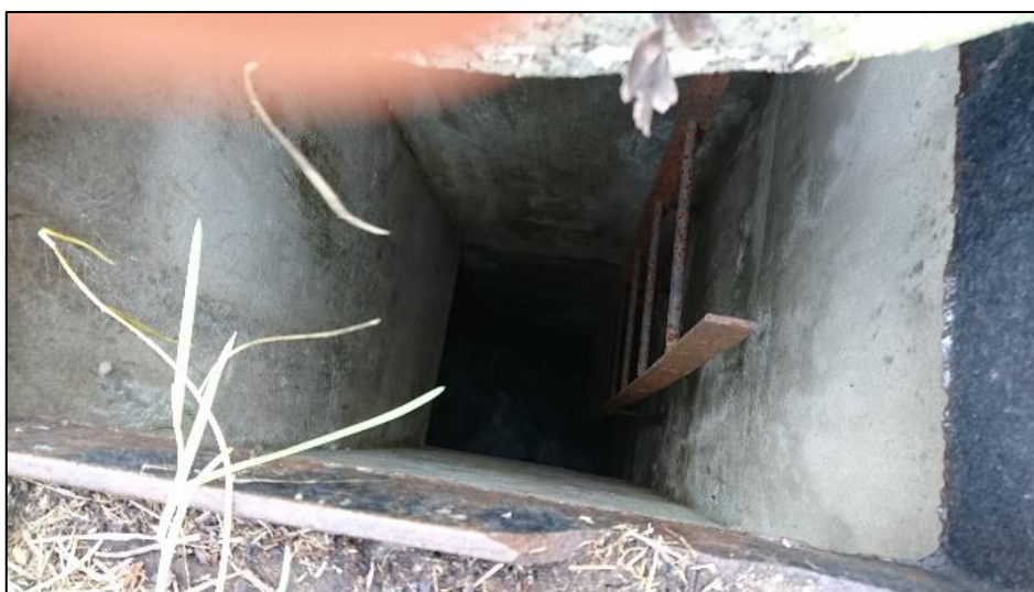
Obrázok 4: Pohľad do kontrolnej šachty na prívodnom potrubí do vodojemu
