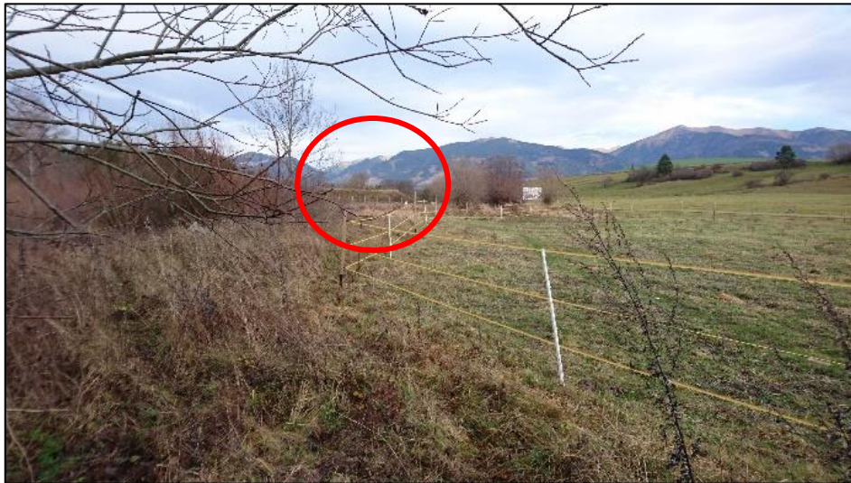
Obrázok 5: Pohľad na vodojem z miesta vyústenia odtoku z priepadu vodojemu
