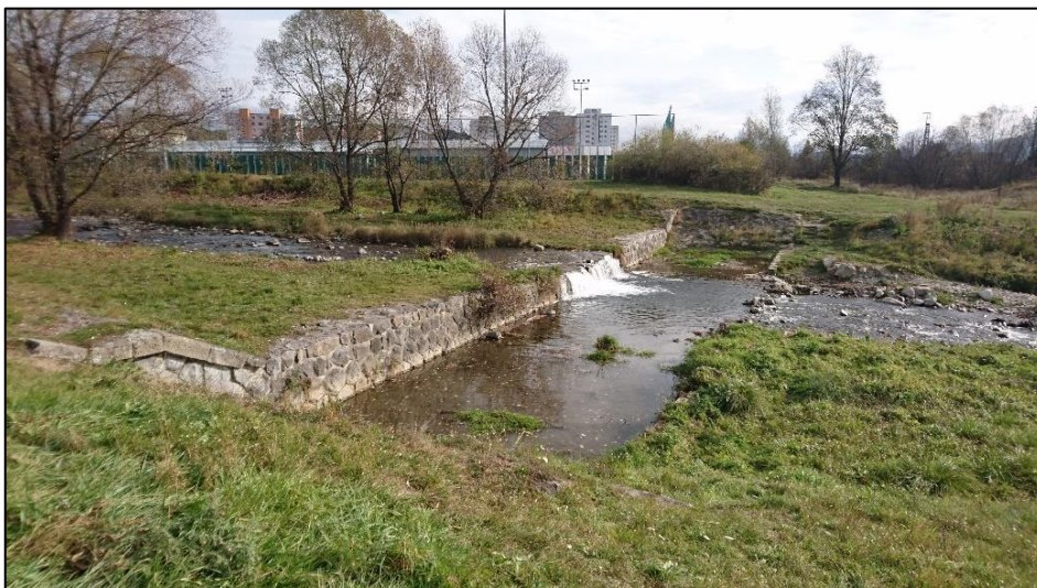
Obrázok 9: Priečna stavba – murovaný kamenný prah – v toku Smrečianka nad železničným mostom
