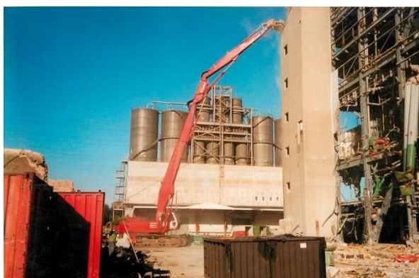
Miesto demolácie. Zdroj: VERAS.
