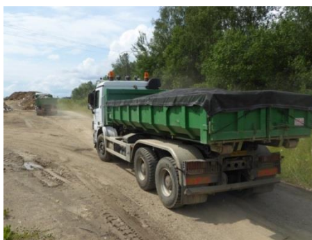
Nákladné auto prevážajúce stavebný odpad a odpad z demolácie, zdroj: A2Conseils sprl.
