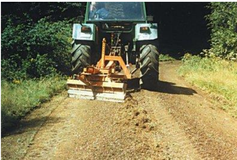
Prídavné zariadenie R2 pri úprave profilu lesnej cesty:
