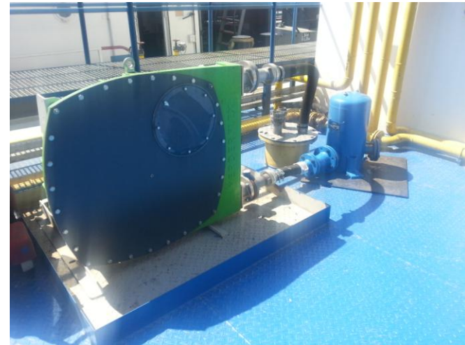
Samonasávacie hadicové čerpadlo na príjem drenážnych vôd
