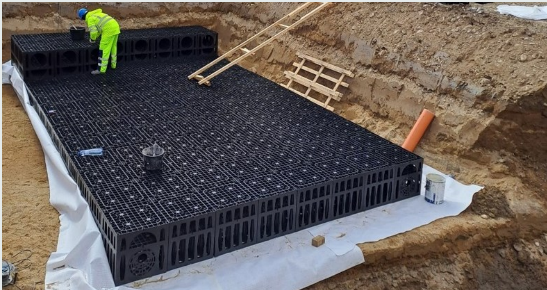
Realizácia vsakovacieho objektu zabudovaného do priepustného podložia
